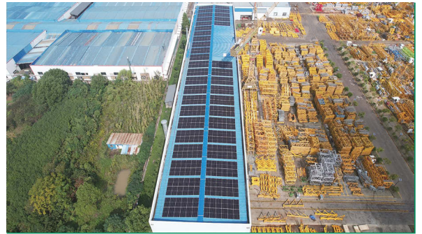
維修中心廠房屋面鋪設太陽能光伏
